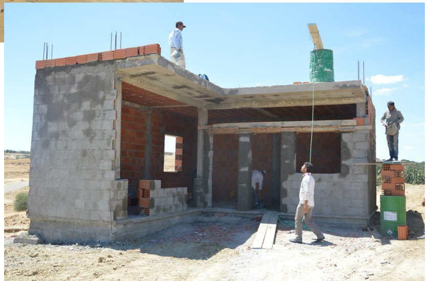
Photos de logements en cour de construction
