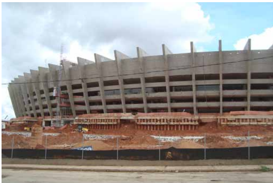
OBRAS PARADAS NO MINEIRÃO EM BELO HORIZONTE. FOTO: LEANDRO UCHOA.
